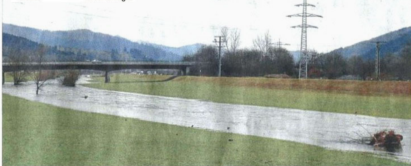
Für die neue Trassenführung müsste möglicherweise die Hochspannungsleitung versetzt werden.
